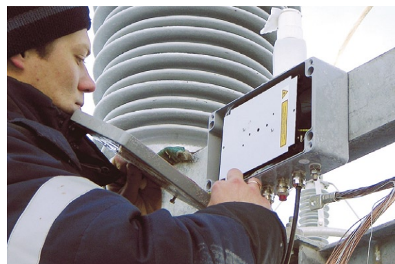
Фото 2 Монтаж сплайс-боксов на ПС «Матвеевская»
